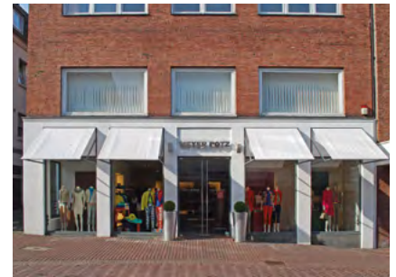
Gelungene Einbindung von Markisen in die Fassadenstruktur
