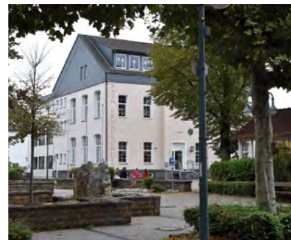
Grundschule mit Platzanlage an der Von-Torck-Straße
