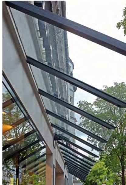
Vordächer aus Glas erlauben Bezüge zwischen Erd- und Obergeschossen
