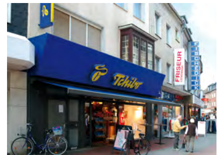
Massive Kragplatten beeinträchtigen die Fassade
