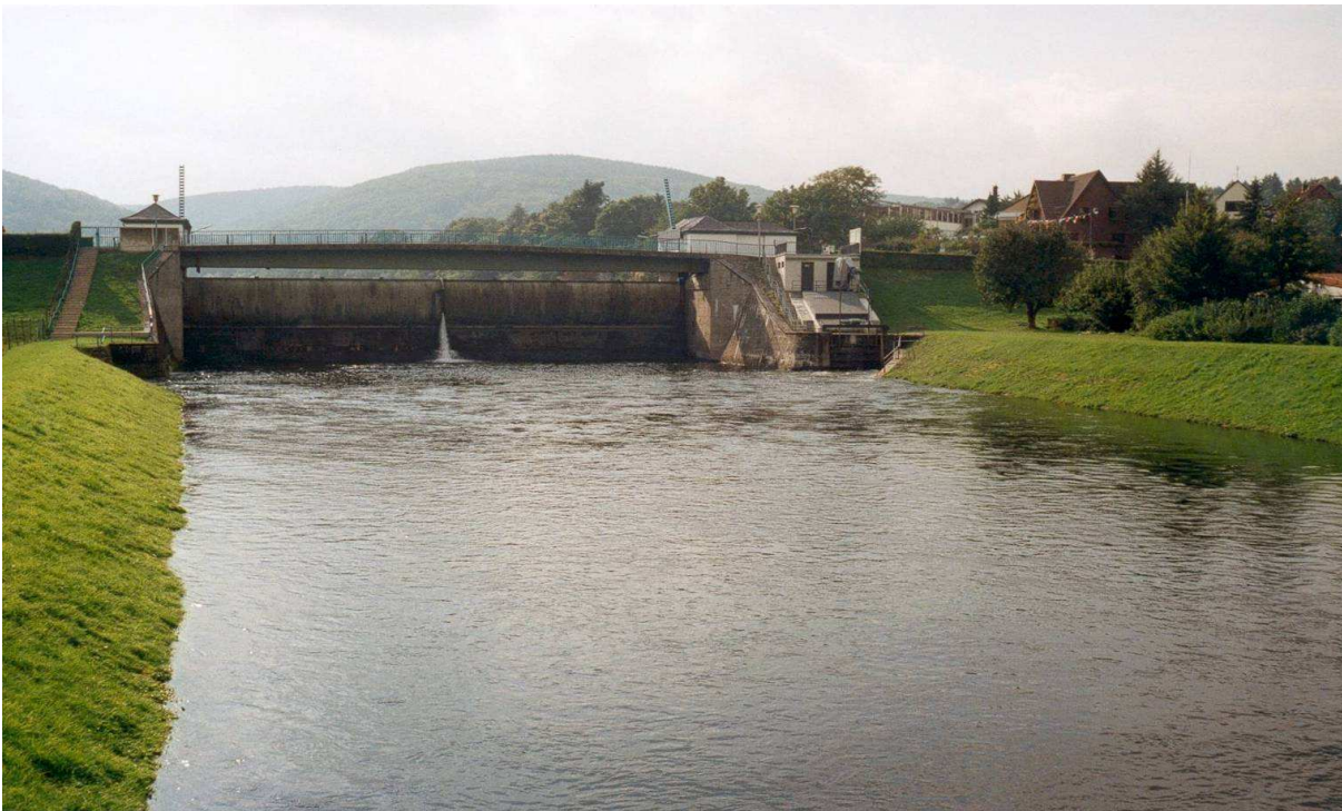
Bildunterschrift: Rückansicht der Staumauer
